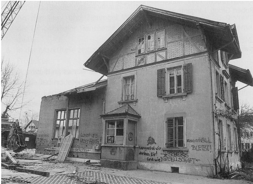
Abbruch der alten Turnhalle und der Abwartwohnung. Foto Margrit Kohler.
