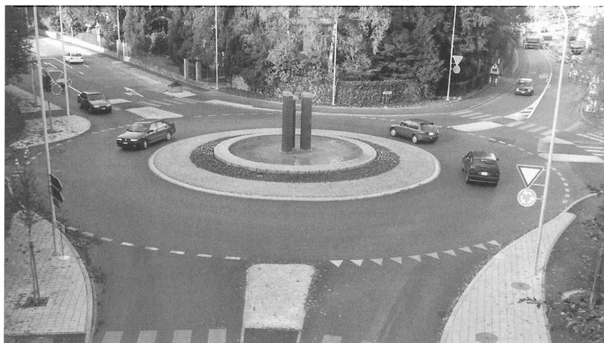
Der neue Kreisverkehrsplatz an der Kreuzung Aarwangenstrasse/Murgenthalstrasse/Waldhofstrasse. Foto aus: Verwaltungsbericht 1997, Stadt Langenthal.
